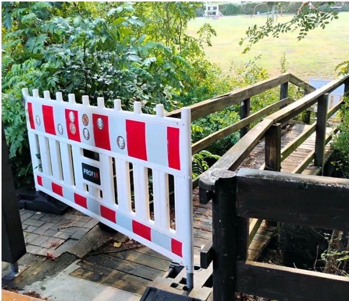
Gesperrte Brücke bei der OF Harxbüttel – Foto: B. Mundlos
